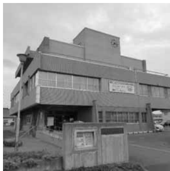
老朽化で対応が急がれる市立図書館
