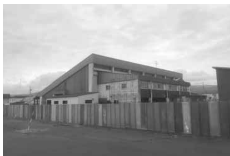
解体作業が進む食品加工流通団地内の旧公設地方卸売市場
