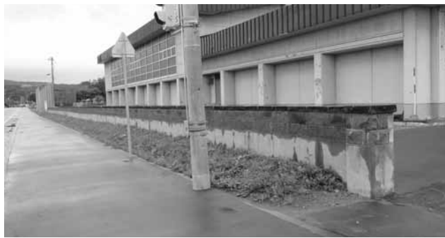
改修された東中学校のブロック塀
