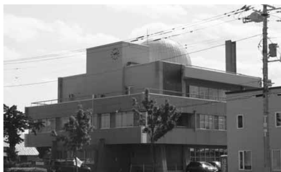
昭和45年に建設された市立名寄図書館。老朽化と狭隘な利用スペースに課題が
