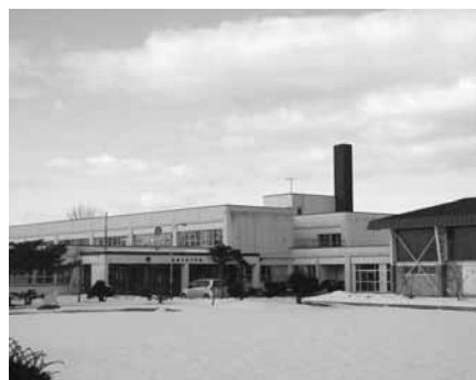
改築検討中の風連中央小学校
