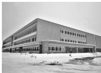
期待されるソフト・ハードの教育環境改善 (南小学校)
