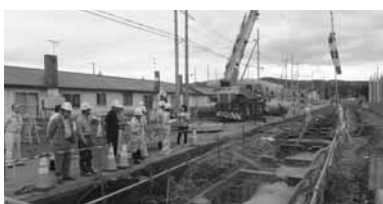
8月20日に雨水管渠整備工事（昭和通）外6カ所の現地調査を行う
