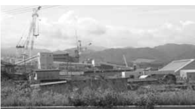
建設中の大間原発
