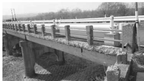
早急な整備が待たれる 18 線橋
