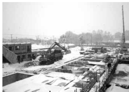
急ピッチで進む 仮称・市民ホールの建設工事
