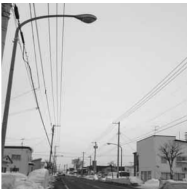
将来のLED化に向けて進む街路灯
