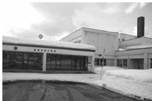
早期改築が望まれる風連中央小学校
