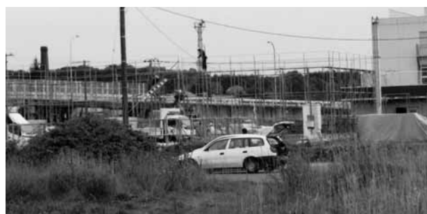
賃貸住宅の建設は始まったが（名寄駅横）
