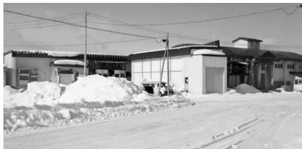
改修する食肉センター
