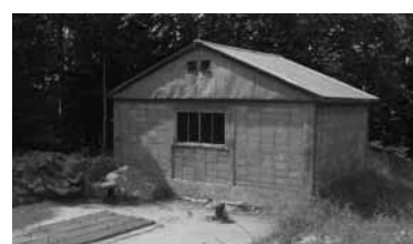
老朽化が著しい風連東生地区飲料水供給施設
