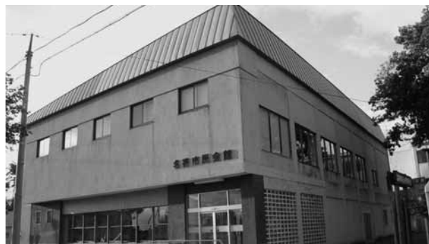
老朽化により改修不可能になった市民会館ホール
