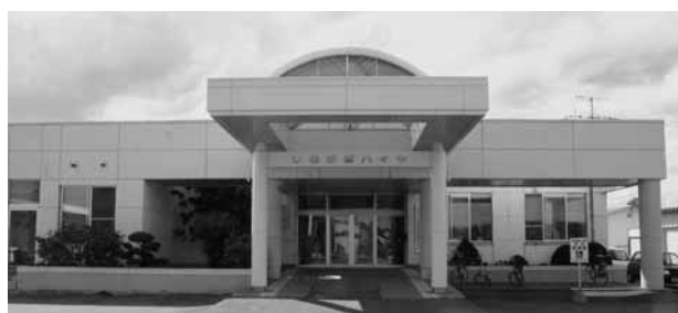
総合計画で整備改修が予定される 風連特養「しらかばハイツ」
