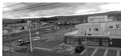
B地区一部が完成し、現在A・C地区の工事がすすめられている風連本町地区
