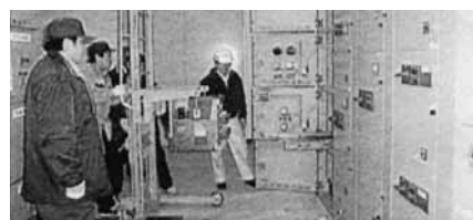
下水終末処理場 主電気室A C Bの状況を調査
