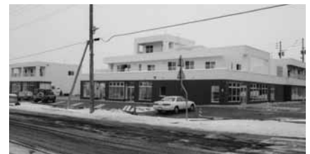
完成した風連本町再開発(Bブロック)
