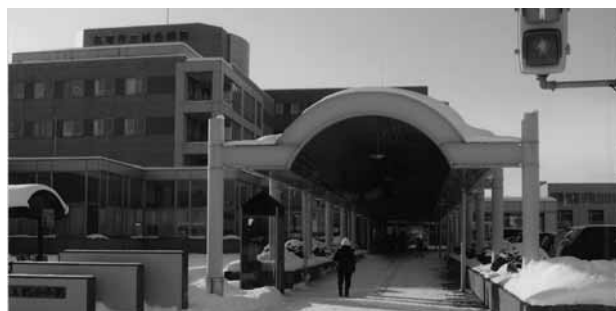
市立総合病院通路（ポロ）にも手すりを設置すべき
