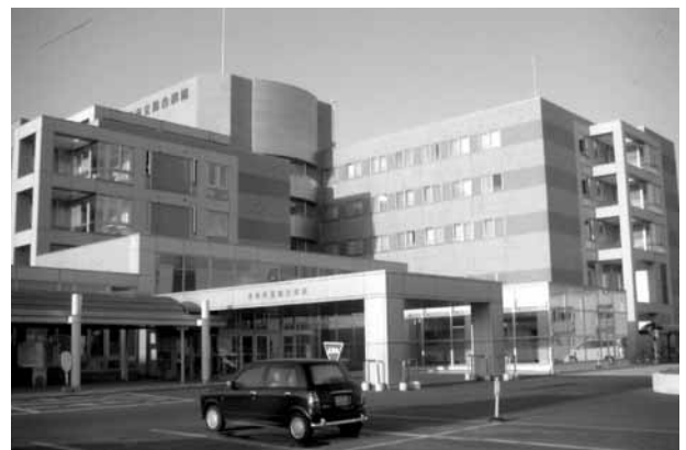
救急外来、ICUの整備が進む市立総合病院
