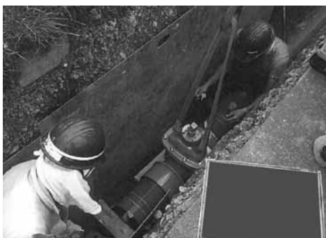
計画的に進められている水道老朽管取り換え工事
