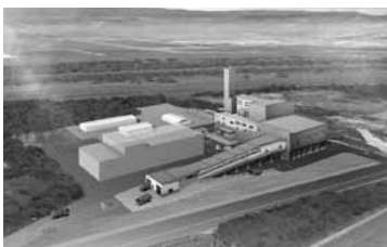
工事が着工した広域ごみ焼却施設(完成予想図) 名寄市負担が33億円以上となる見込み
