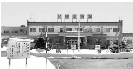
老朽化した東病院。移転か改修か？
