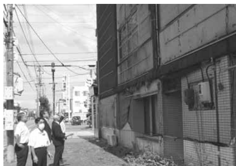
空き家の現地状況調査
