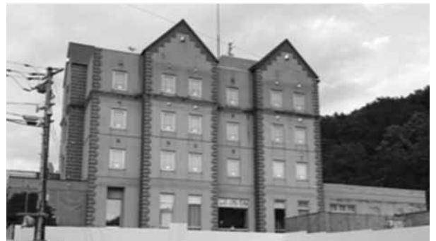
温浴施設を改修中のなよろ温泉サンピラー
