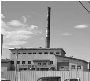
焼却施設解体工事
