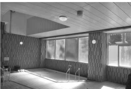
来年3月から改修工事が始まるなよろ温泉サンピラー
