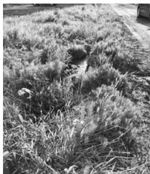
災害に強い道路側溝の整備を
