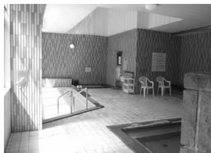
改修工事が先送りとなった「なよろ温泉サンピラー温浴施設」
