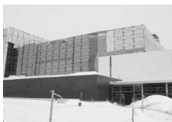
急ピッチで工事が進む市民ホール
