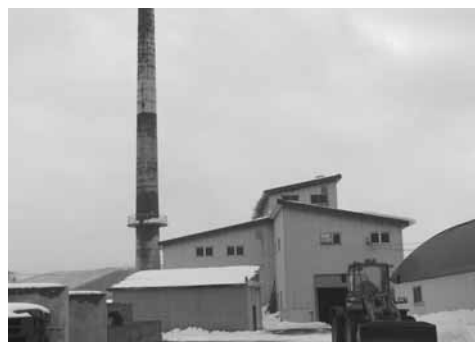
解体が求められている旧焼却施設
