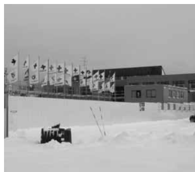
建設が進む(仮称)市民ホール
