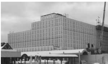
工事が進む市立総合病院
