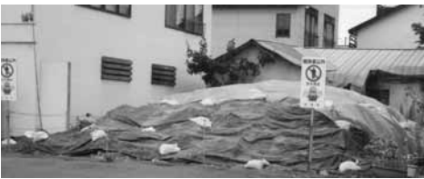
解体されたままの住居跡
