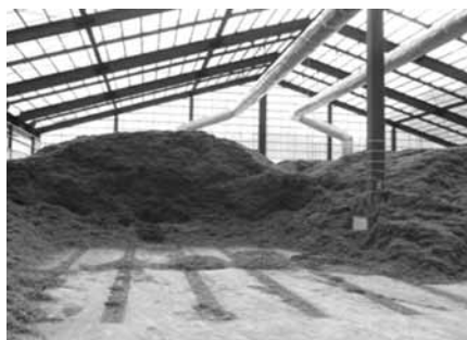
雪氷冷熱と太陽光熱を利用した南富良野町の「木質チップ乾燥施設」
