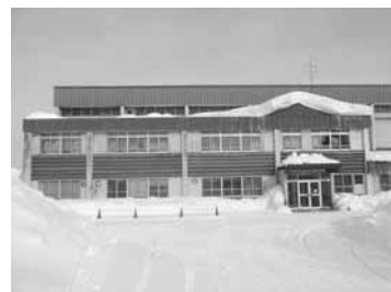
アスベストが確認された公設市場
