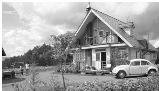
取り壊しとなった映画「星守る犬」のロケセット
