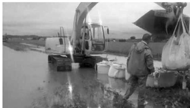
10年前にもはん濫をした風連地区南側を流れる真狩川
