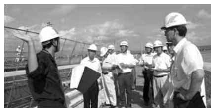
19線道路 加東橋上部工の視察
