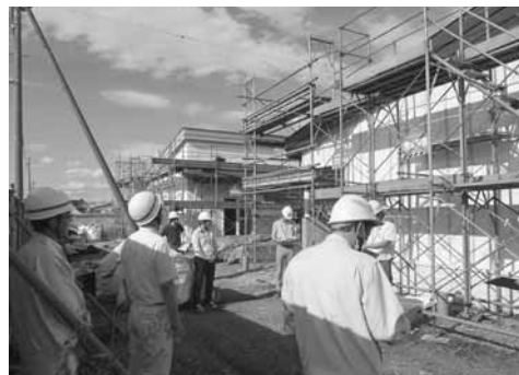
10月31日完成を目指し建設が進む瑞生団地
