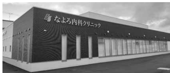
開業医誘致条例を初めて活用して開院された「なよろ内科クリニック」
