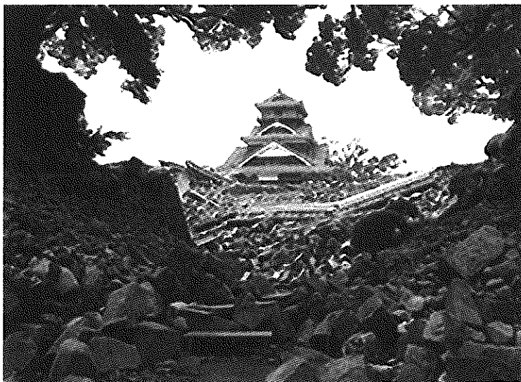
熊本県のシンボル「熊本城」も大きな被害を受けました
