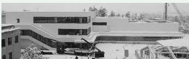
▲新図書館工事のようす（外装が完成しました）
