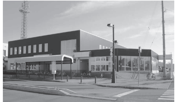
建設中の駅前交流プラザ「よろーな」
