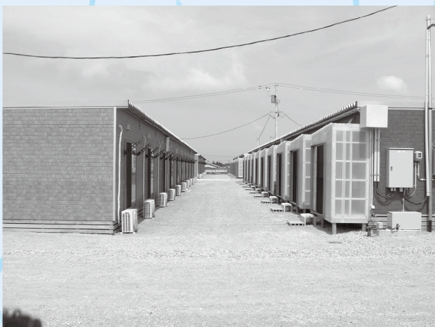
建設されている仮設住宅
