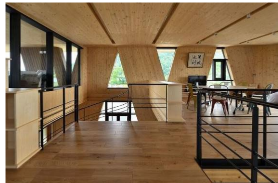
道産トドマツの CLT による民間社屋 /北海道士別市 (株)イトイグループホールディングス CLT 新社屋 写真：KEN 五島
