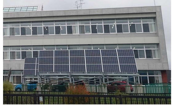
図 3.10 建物(敷地)への太陽光設置事例 (名寄市立名寄南小学校)
