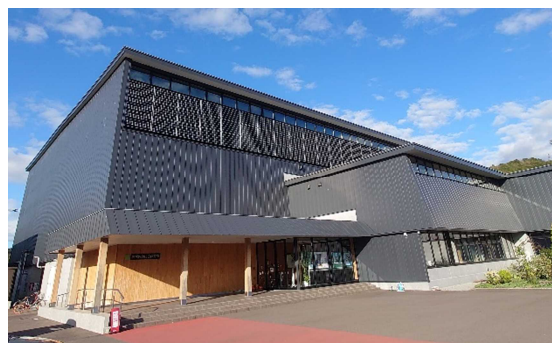
図 7.6 壁への太陽光発電設置事例
