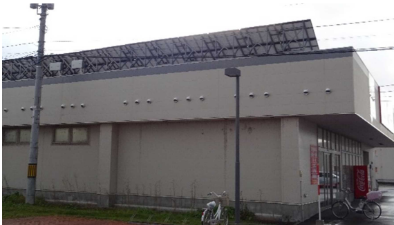
図 3.9 建物屋根への太陽光設置事例
