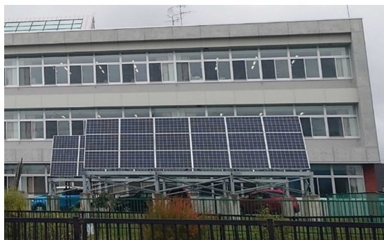
図 7.5 名寄南小学校敷地での太陽光発電設置状況 (10kW)
