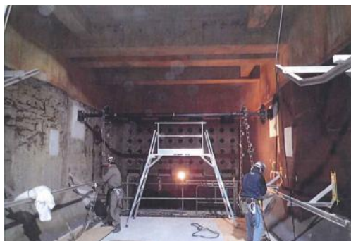
(施行状況・No.3 終沈汚泥掻寄機)
