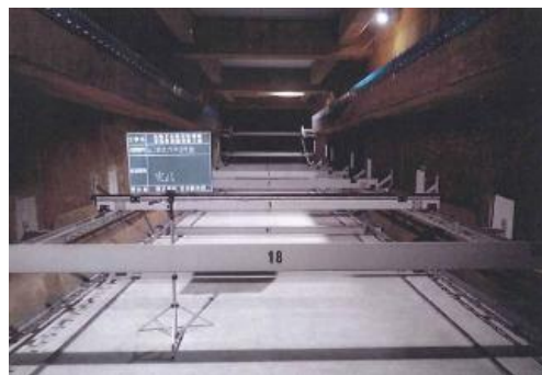
(施行完了・No.3 終沈汚泥掻寄機)
