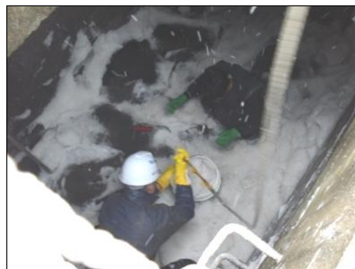
写真 4 沈砂池に侵入したアイスジャムをバケツリレーで除去
