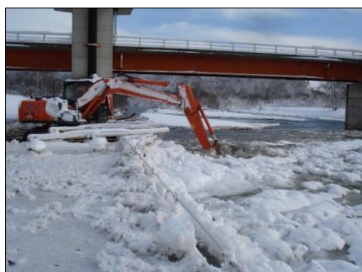
写真 6 取水口に堆積したアイスジャムを重機で除去
