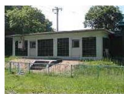
風連日進浄水場
