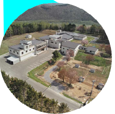
空から見た緑丘浄水場
