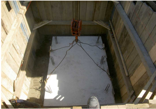
(施工写真①・底版据付)
