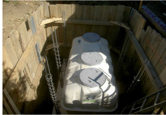
(施工写真②・浄化槽設置)
