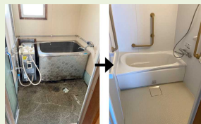
浴室 改修前(現状) → 改修
