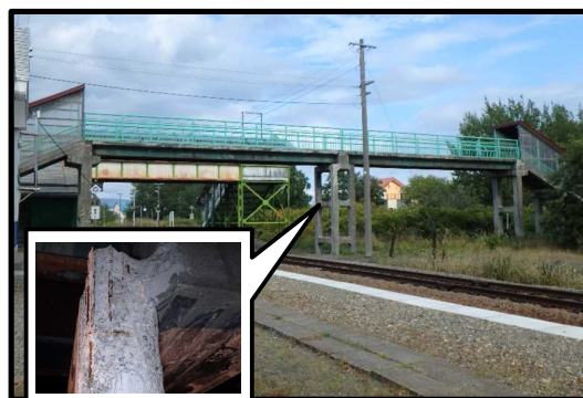
風連駅跨線橋(橋梁長寿命化事業)
