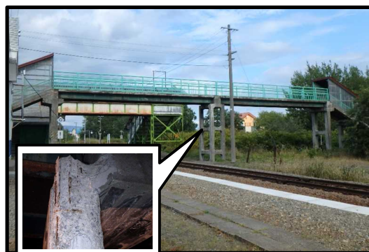
風連駅跨線橋(橋梁長寿命化事業)
