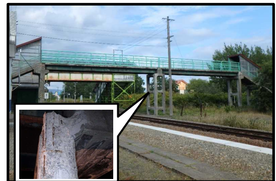
風連駅跨線橋（橋梁長寿命化事業）
