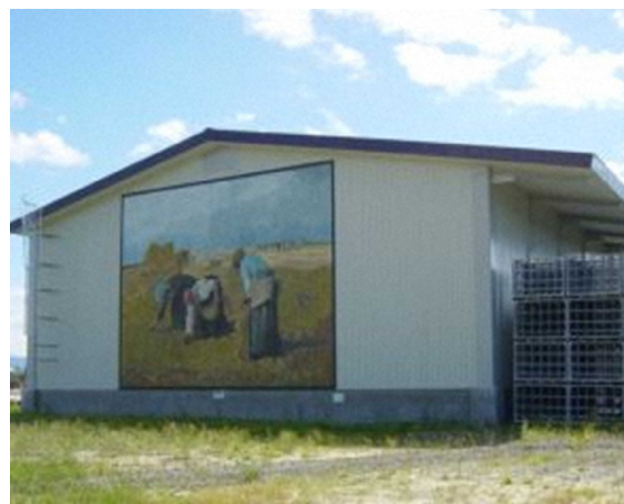
【農産物出荷調整利雪施設】
