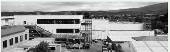
▲新図書館工事のようす (外壁が現れました)
