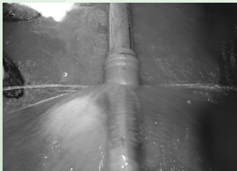
老朽化により破損した水道管
