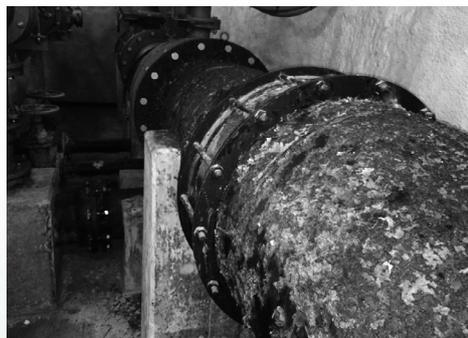
施設内配管 (錆びによる劣化が激しい)
