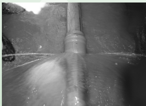
老朽化により破損した水道管
