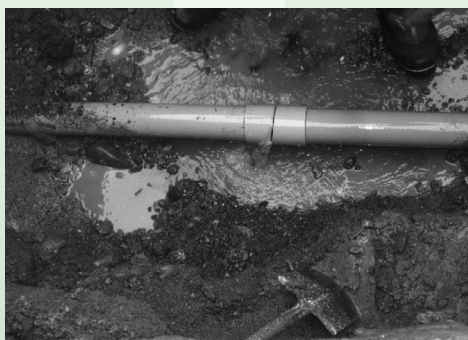
老朽化により破損した水道管
