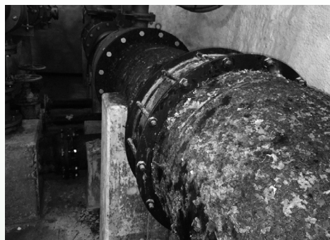
施設内配管 (錆びによる劣化が激しい)
