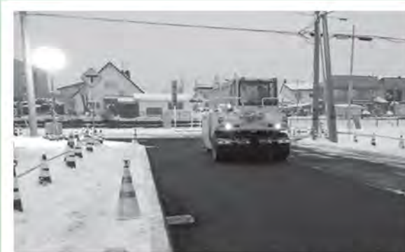
徳田1号線道路改良舗装工事 6,473万5千円
