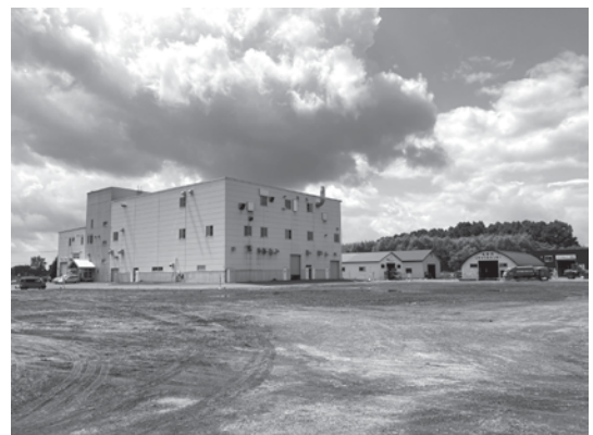
▲旧名寄市清掃センター解体跡地
